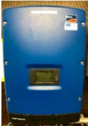
Kuva 49. Aurinkosähköinvertteri, Sunny Tripower STP 5000TL-20
